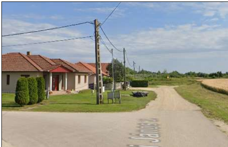
Meglévő vasbeton oszlopos, légkábeles elektromos vezeték az Irinyi János utca déli irányú meghosszabbításában /Forrás: KIRA Street View/
