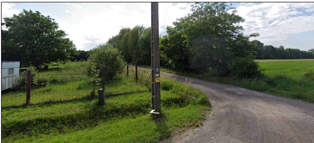
Nyíltárkos csapadékvíz elvezetés az Árpád utca Várdomb utcai útsatlakozásánál
